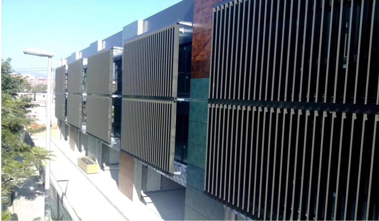
**Lama de 210mm en posición vertical. Automatizada**
